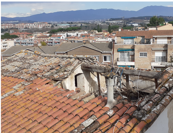
Coberta Zona B
