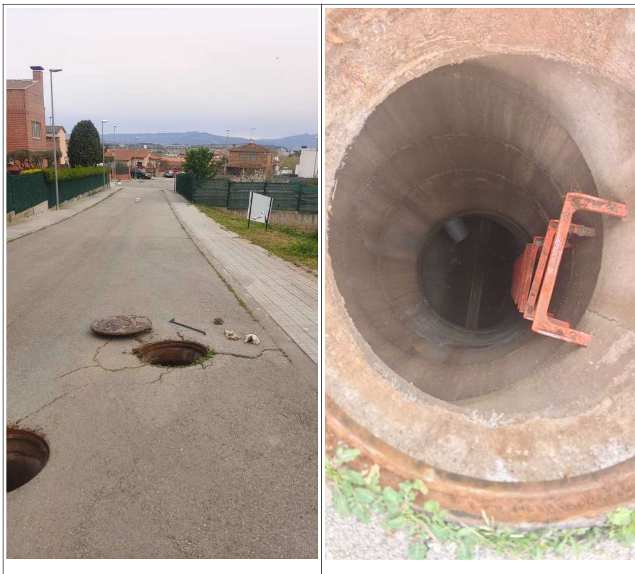
Foto 2 Obertura de tapes de registre i detecció de la canalització del torrent
