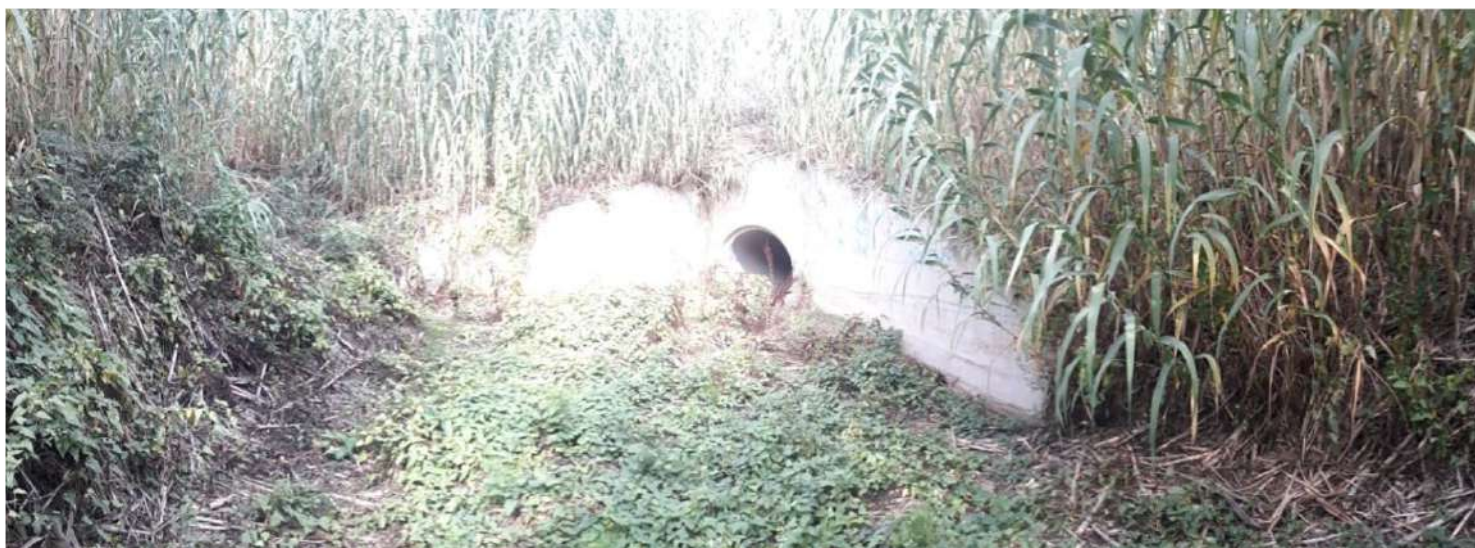
Foto 21 – Zona de recepció del pas inferior
