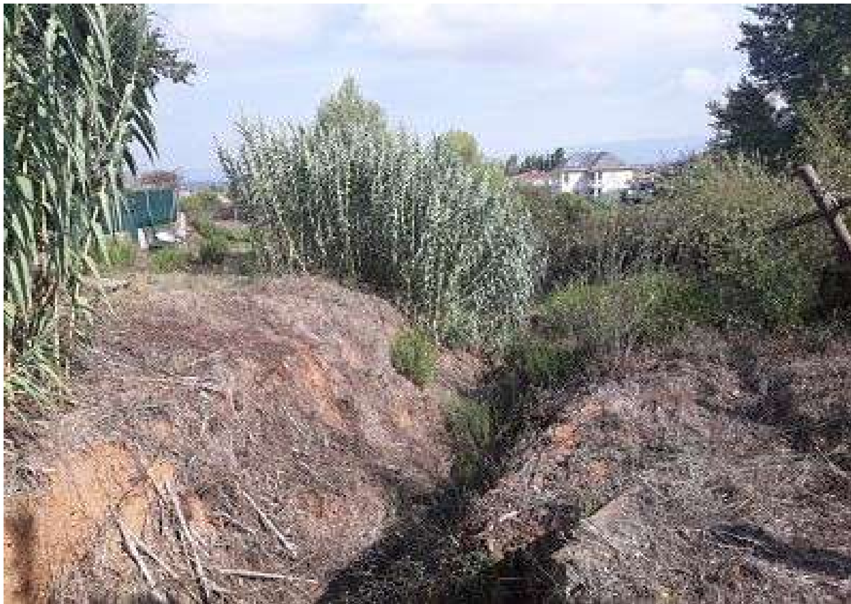
Foto 4 – Continuació del Torrent Can Sala
