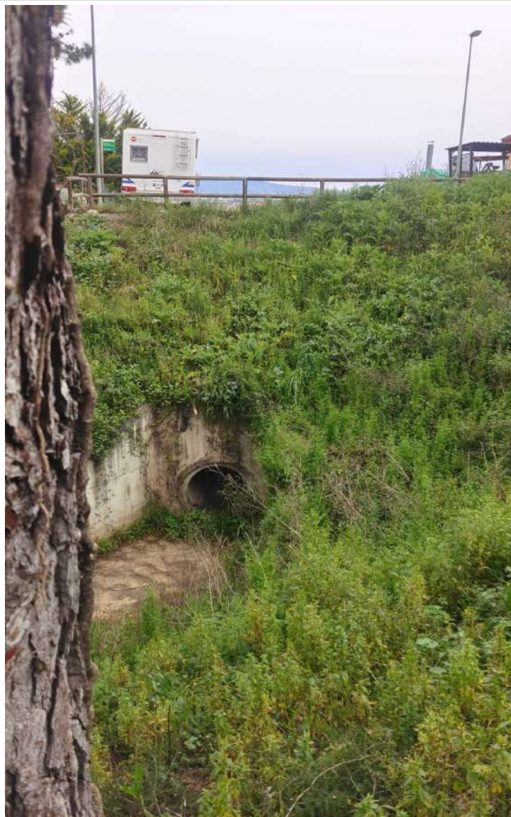
Foto 1 inici de la canalització del torrent de Can Paisà a la cantonada entre el carrer Almogàvers i Rafel de Casanova
