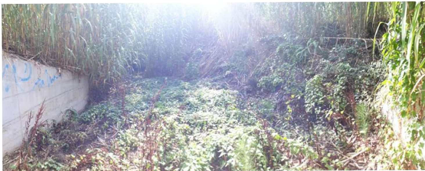
Foto 20 – Vista aigües amunt des del pas inferior
