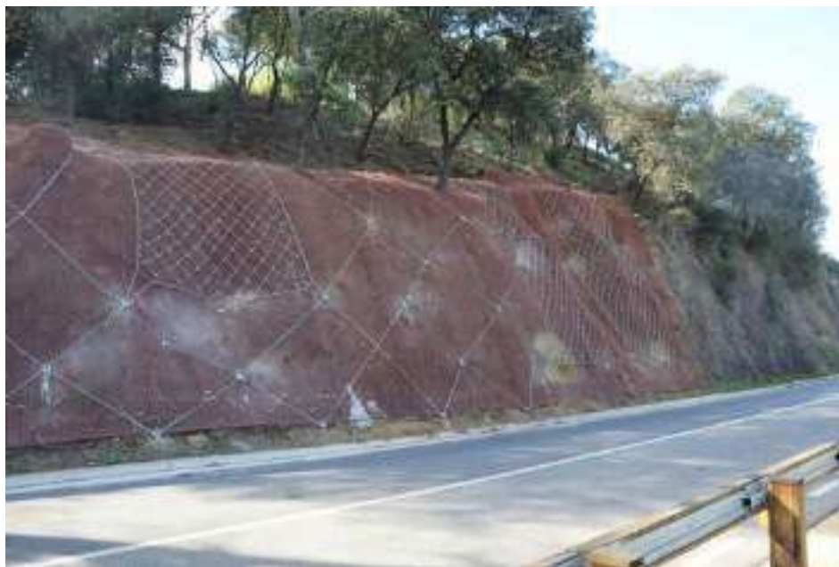
Fotografia 13: Imatge del talús recentment reforçat amb malla junt la BV-5001.
