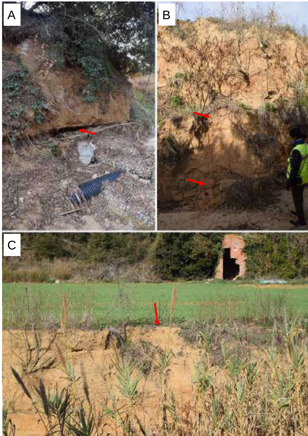
Fotografia 10: Riera de Vallromanes. (A) Soscavament (fletxa vermella) produït per les successives avingudes. (B) Petit despreniment recent sobre els materials fins d'un dels marges, la fletxa de dalt indica la cicatriu, la de sota els materials caiguts. (C) Exemple d'una cicatriu (fletxa vermella) d'un lliscament amb afectació als camps de cultiu que limiten amb la riera.
