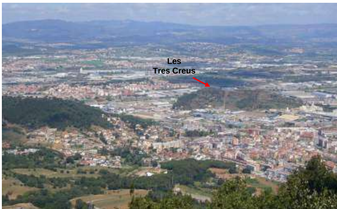
Fotografia 2: Vista general de l'àmbit d'estudi i entorn des del Castell de Montornès. Al fons, el turó de les Tres Creus. Font: Ricard Ballo (any 2008).
