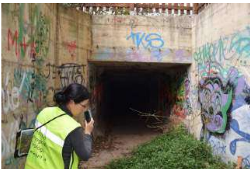
Fotografia 5: Entrada de la canalització de soterrament del torrent de Ca n'Oliver, a l'altura del carrer de Can Coll i que travessa el municipi fins a la seva desembocadura a el Mogent. A la imatge s'observen les dimensions de la canalització (d'aproximadament 2 x 2 m).
