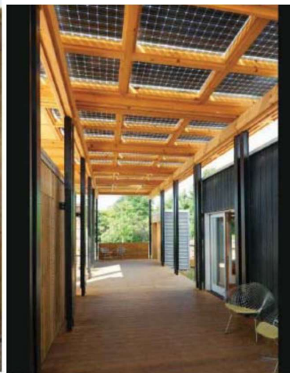
PASSADÍS EXTERIOR AMB COBERTA FOTOVOLTAICA
