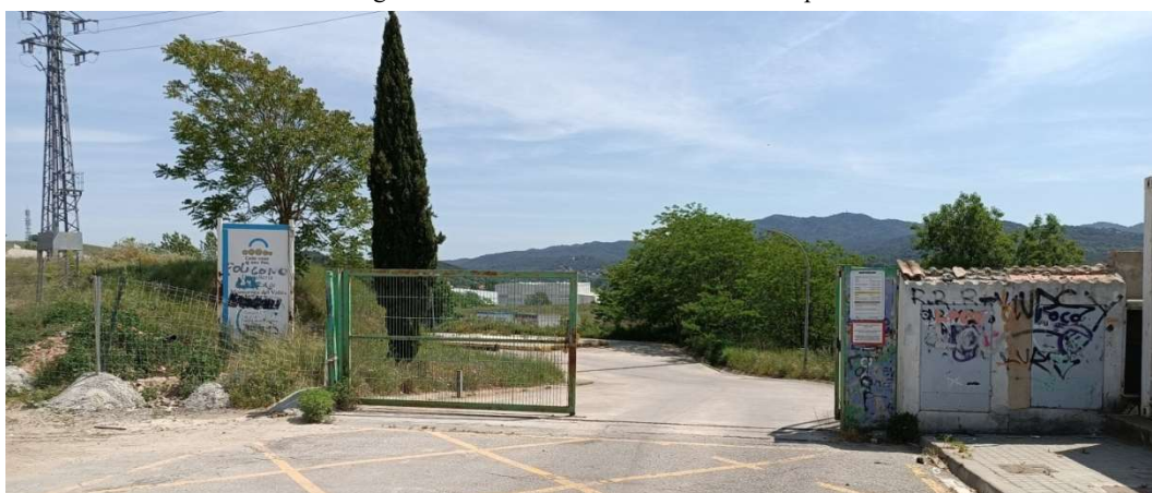
Imatge 3. Accés actual a la deixalleria municipal
