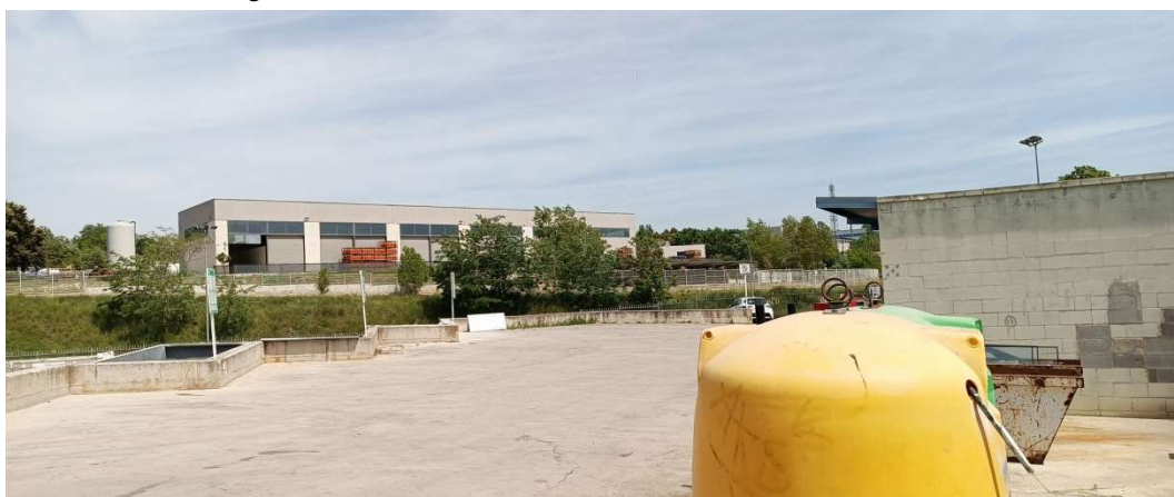
Imatge 4. Interior de la deixalleria i naus situades a l'entorn de la mateixa
