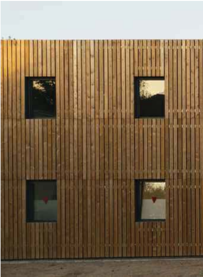
TANCAMENT DE FAÇANA AMB FUSTA
