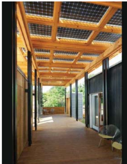
PASSADÍS EXTERIOR AMB COBERTA FOTOVOLTAICA
