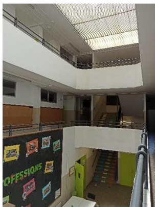
Buit central a l'edifici d'educació primària
