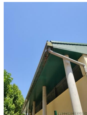
Detall de l'edifici del gimnàs
