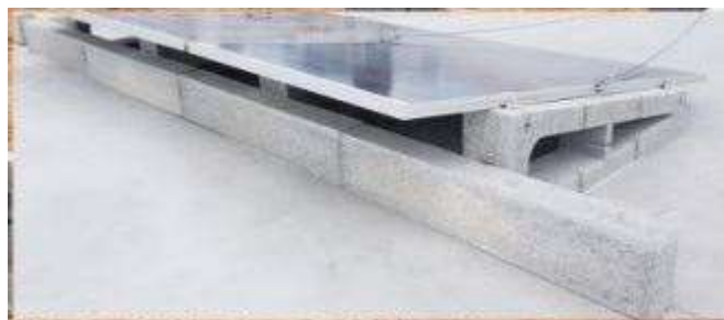
Imatge 9. Fixació dels panells i dels llasts als suports
