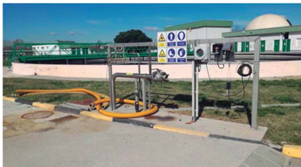
Imatge 10. Zona descàrrega residus i matèries primeres
