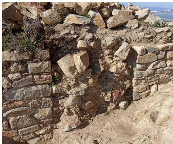
Portal o pas en el mur, que es preveu recuperar
