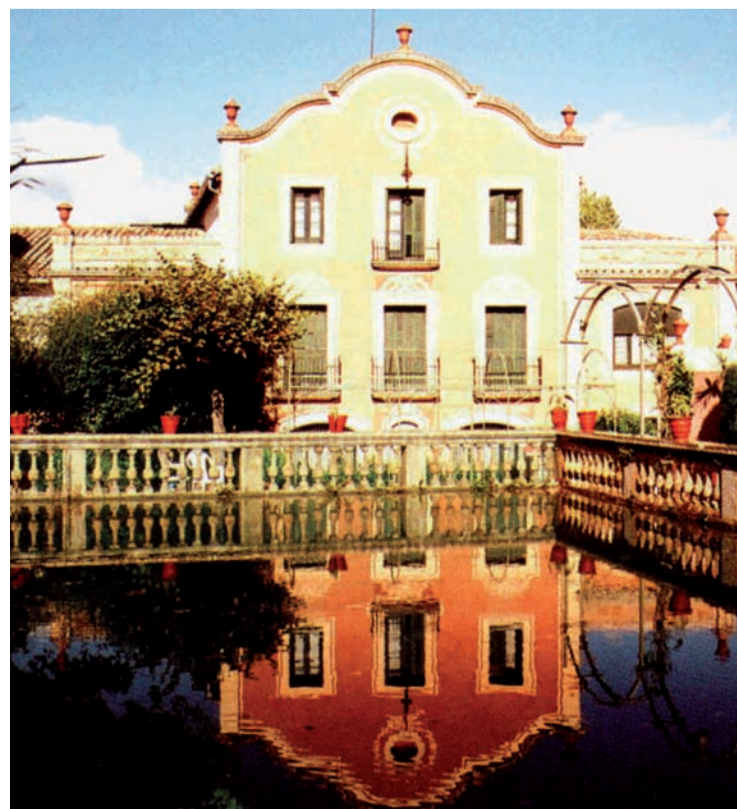
MAS VILALLONGA. L'edifici data de l'any 1913.
