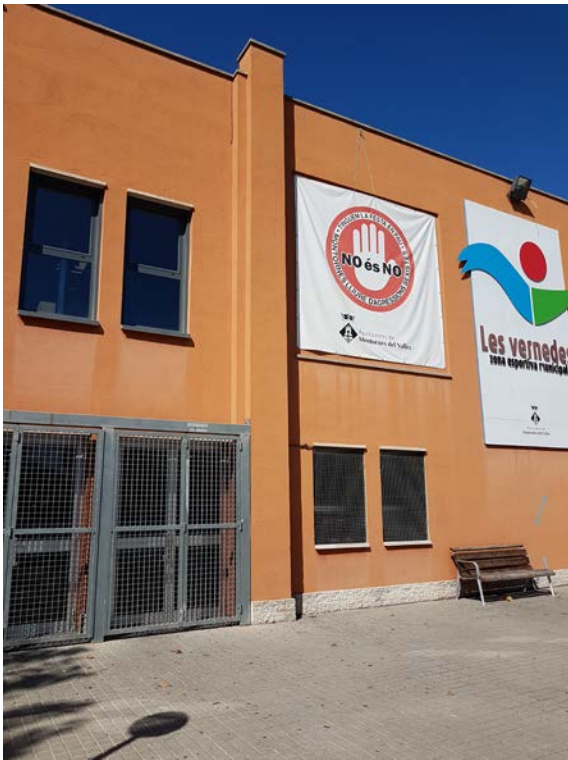
Accés exterior Pavelló municipal
