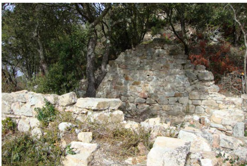
Murs sud i nord
