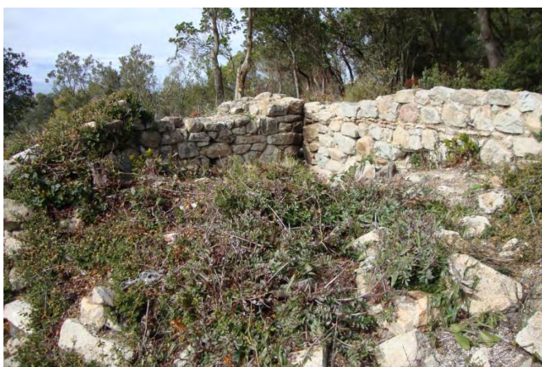
Estructura adossada al costat sud de la capella
