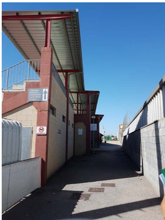
Accés exterior grades pista Atletisme
