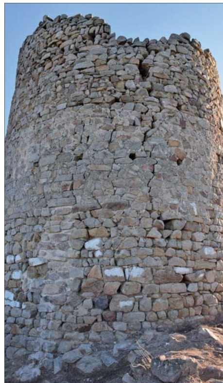
TORRE DE L'HOMENATGE
