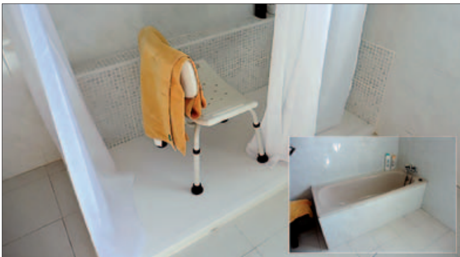
UNA DE LES ADAPTACIONS REALITZADES PER MILLORAR L'ACCESSIBILITAT AL BANY
