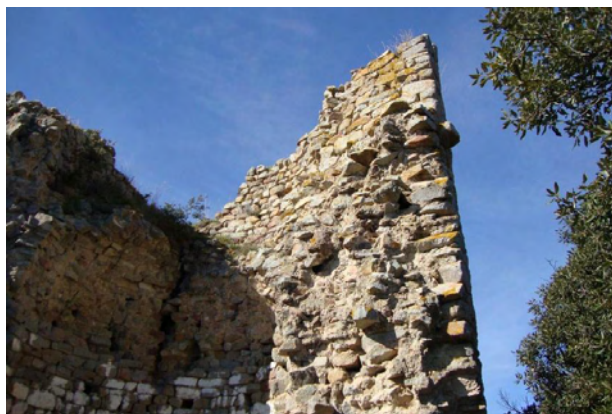
Vista de brancal d'una antiga obertura (a la part alta de la fotografia)
