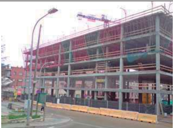
Foto 01: Abans de cap actuació es realitzarà el tancament perimetral d'obra.
