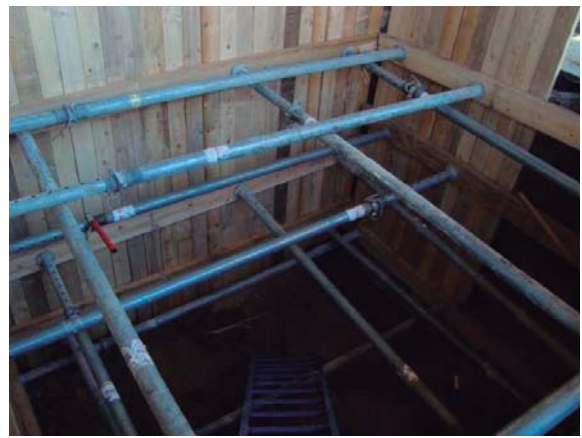
Foto 03: Els puntals a utilitzar estaran en un bon estat ús, en cas contrari no es col·locaran
