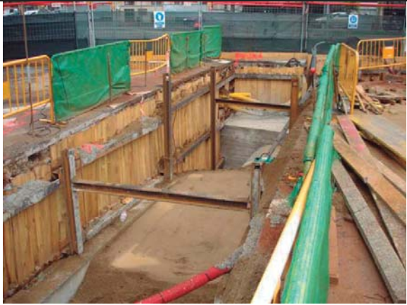
Foto 02: L'amplada de la rasa serà el suficient per garantir la col·locació de l'estintolament
