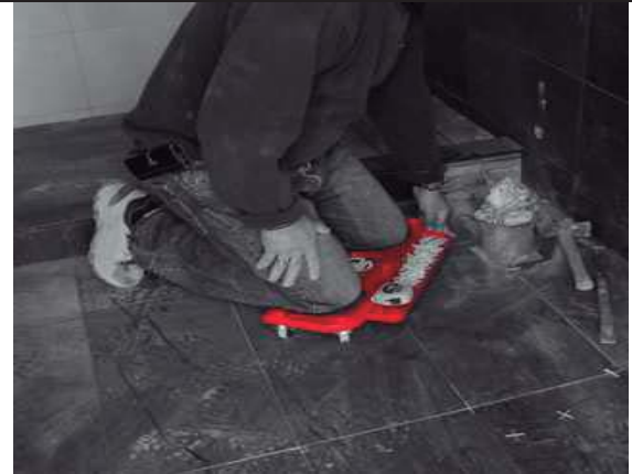
Foto 03: Per la col·locació de paviments, es recomanable que els operaris portin genolleres.
