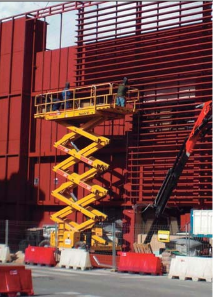
Foto 02: La zona de treball, estarà degudament delimitada amb tanques mòbils.
