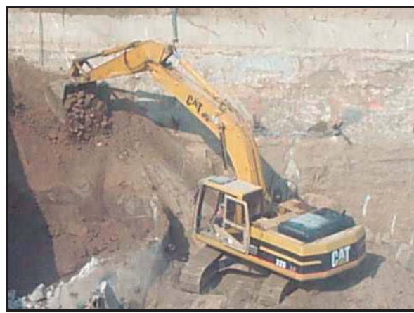
Foto 01: Evitarem proximitat a talls verticals que suposin bolcades de la maquinària.
