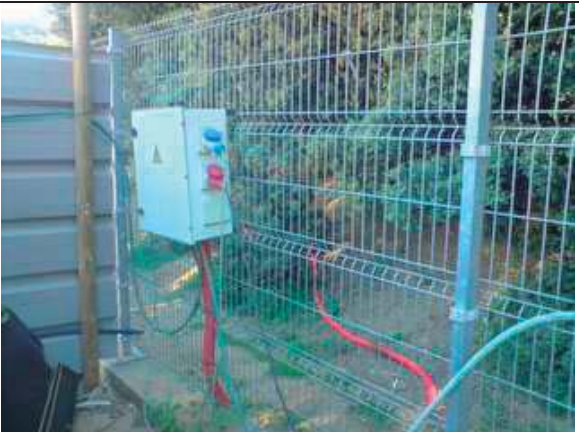
Foto 06: Tindrem cura de les instal·lacions provisionals d'obra.
