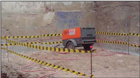
Foto 02: A nivell del sòl, s'acotaran les àrees de treball
