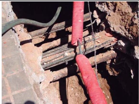
Foto 02: Es realitzaran cates per localitzar els serveis existents a la zona abans d'iniciar els treballs d'excavacions.
