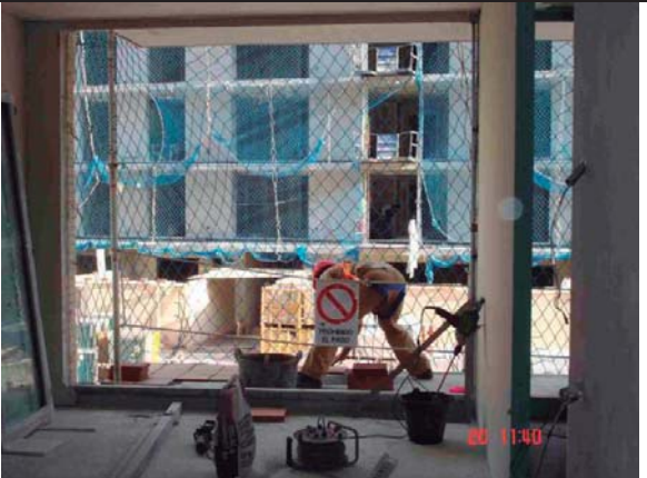
Foto 04: En treballs en que no es pugui col·locar una protecció col·lectiva, l'operari portarà arnés de seguretat i es lligarà a punt fixe o línia de vida habilitada. La zona de treball, estarà delimitada amb
