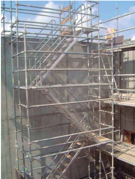
Foto 01: S'habilitaran bastides tubular amb escales per accés a interiors d'excavacions i diposits.
