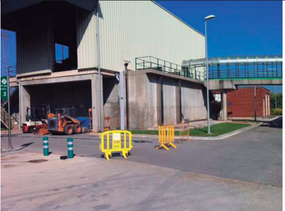
Foto 04: Les zones de treball, quedaran degudament senyalitzades i delimitades amb tanques mòbils o cintes de balisar
