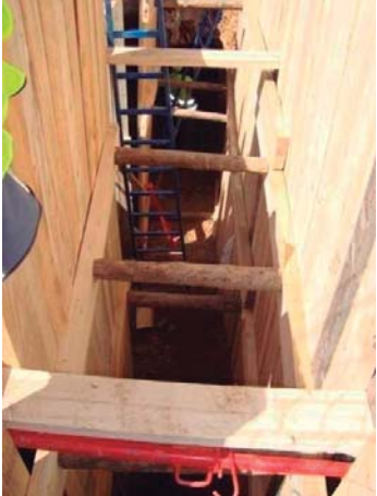
Foto 02: L'amplada de la rasa serà el suficient per garantir la col·locació de l'estintolament
