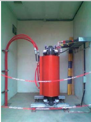
Foto 01: La zona de treball estarà degudament delimitada.
