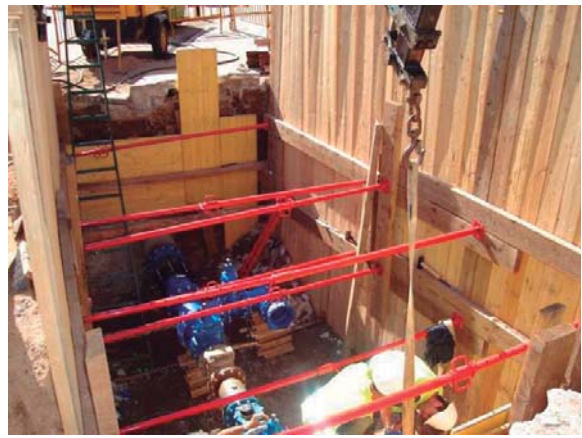
Foto 01: L'espai entre puntals serà el suficient per poder treballar i segons indiqui el càlcul de l'estintolament.
