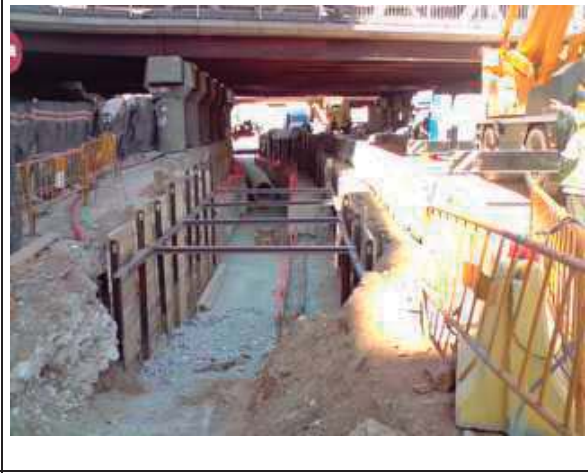
Foto 04: Es realitzaran estintolaments de les excavacions.
