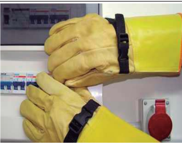
Foto 04: Els operaris faran ús dels E.P.I.'s necessaris per evitar el contacte elèctric.
