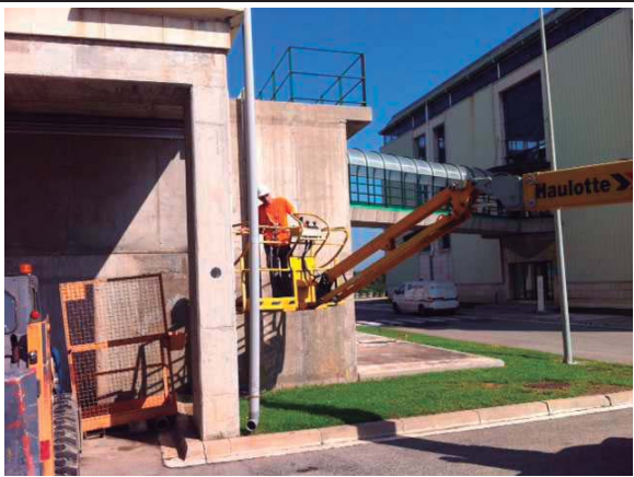
Foto 01: Per col·locació de canalitzacions exteriors, es farà ús de mitjans auxiliars adequats
