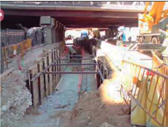
Foto 04: Es realitzaran entibacions de les excavacions de rases.
