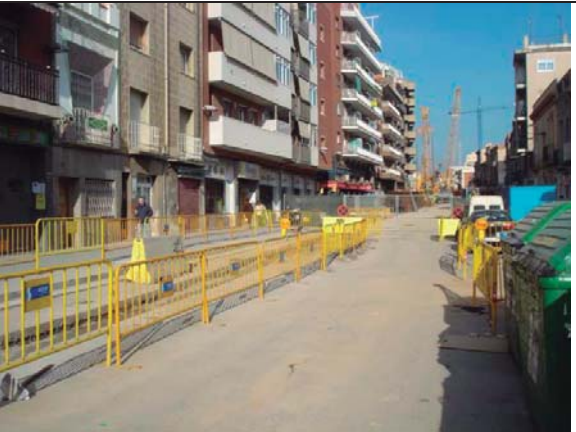
Foto 02: La zona de treball estarà en tot moment degudament delimitada i senyalitzada
