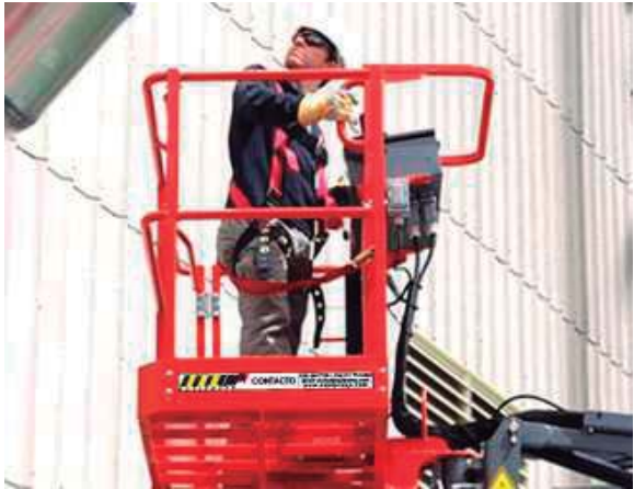
Foto 01: En tot moment els operaris portaran arnés de seguretat durant els treballs a les plataformes elvadores mòbils.
