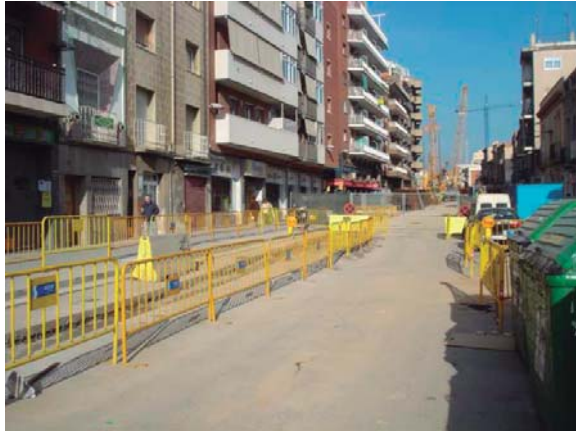
Foto 03: La zona de treball estarà en tot moment degudament delimitada i senyalitzada
