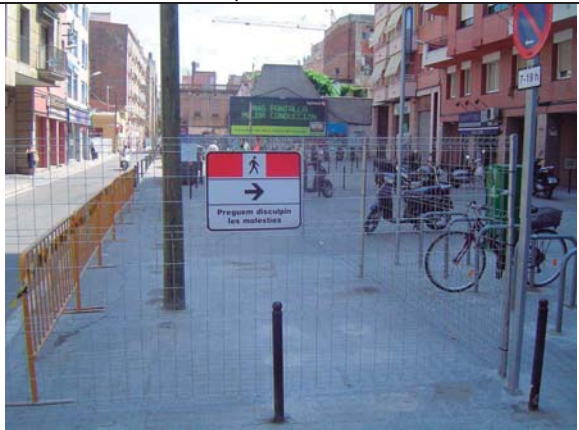
Foto 03: Les zones exteriors d'obra estaran degudament senyalitzades
