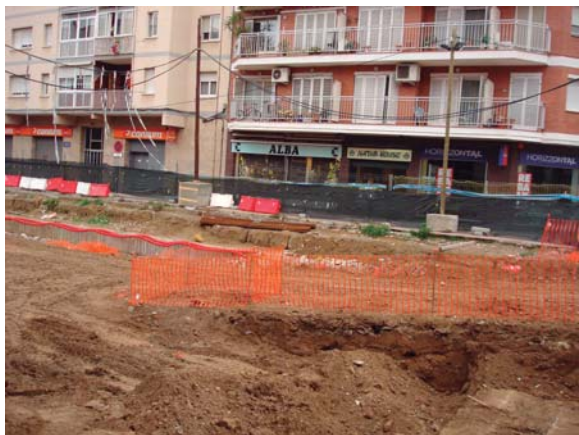
Foto 03: Senyalitzarem adequadament els desnivells i les diferents zones de pas en interior d'obra.
