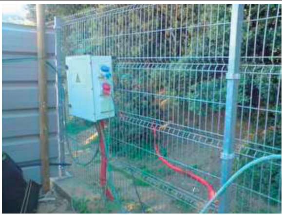
Foto 05: Tindrem cura de les instal·lacions provisionals d'obra.
