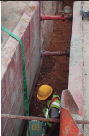
Foto 02: Es col·locaran estintolament de rases adequats per cada tipus d'excavació.
