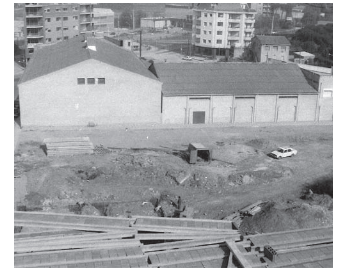
VISTA DEL CINEMA I EL TEATRE, EL 3 NOVEMBRE DE 1978, MENTRE ES FEIEN LES OBRES DE CONSTRUCCIÓ DE L'AULARI DEL CARRER DE SANT ISIDRE. AMMV. EXPEDIENT CX. 848.
