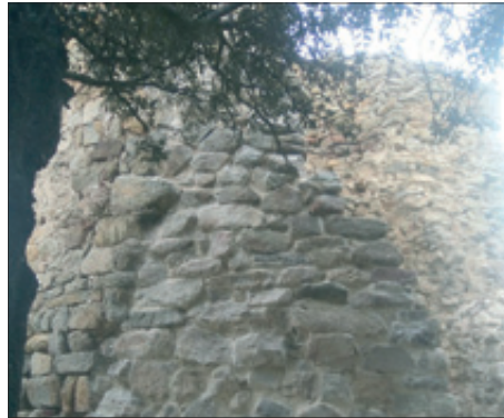
RESULTAT DELS TREBALLS DE CONSOLIDACIÓ DE LA TORRE
