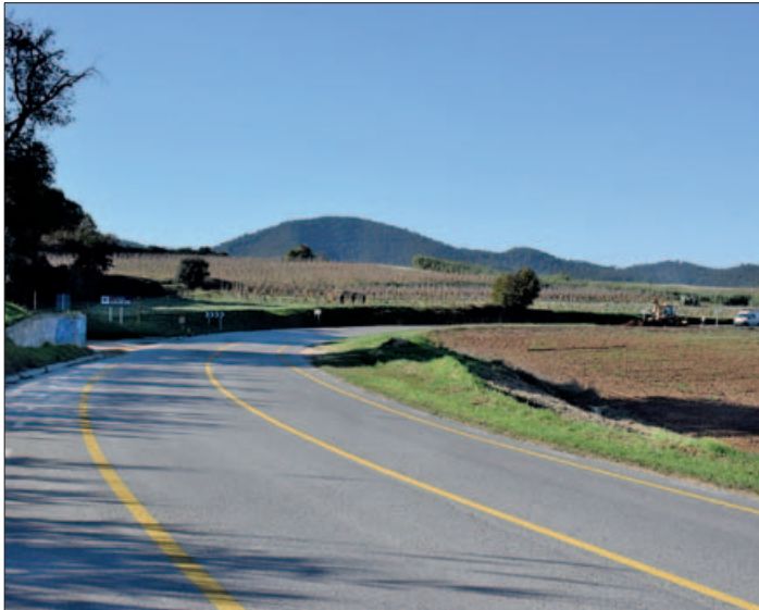
VISTA DEL REVOLT I L'ACCÉS AL CAMÍ DE CAN CUBEROT
