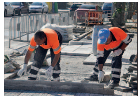
OPERARIS DE LA BRIGADA MUNICIPAL D'OBRES CONTRACTATS A TRAVÉS DELS POL
