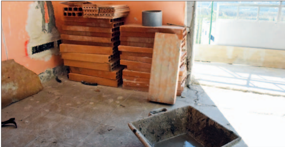
INTERIOR DEL PRIMER HABITATGE EN FASE DE REHABILITACIÓ
