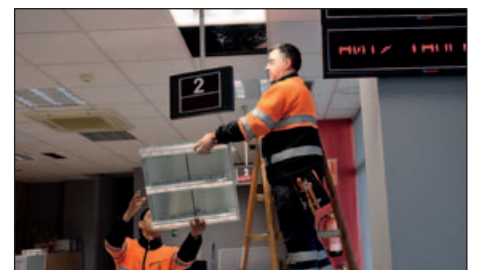
SUBSTITUCIÓ DE LES LLUMINÀRIES A L'EDIFICI DE L'AJUNTAMENT
