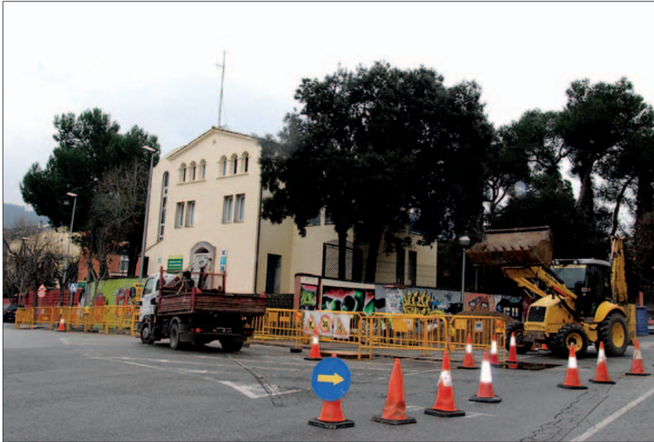
OBRES DE MILLORA DE LA XARXA DE SUBMINISTRAMENT D'AIGUA A LA PL. DELS PAÏSOS CATALANS
