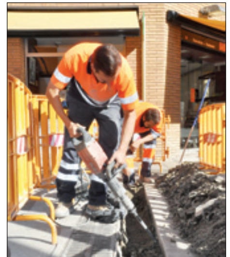
TREBALLS DE MILLORA AL CARRER MAJOR
