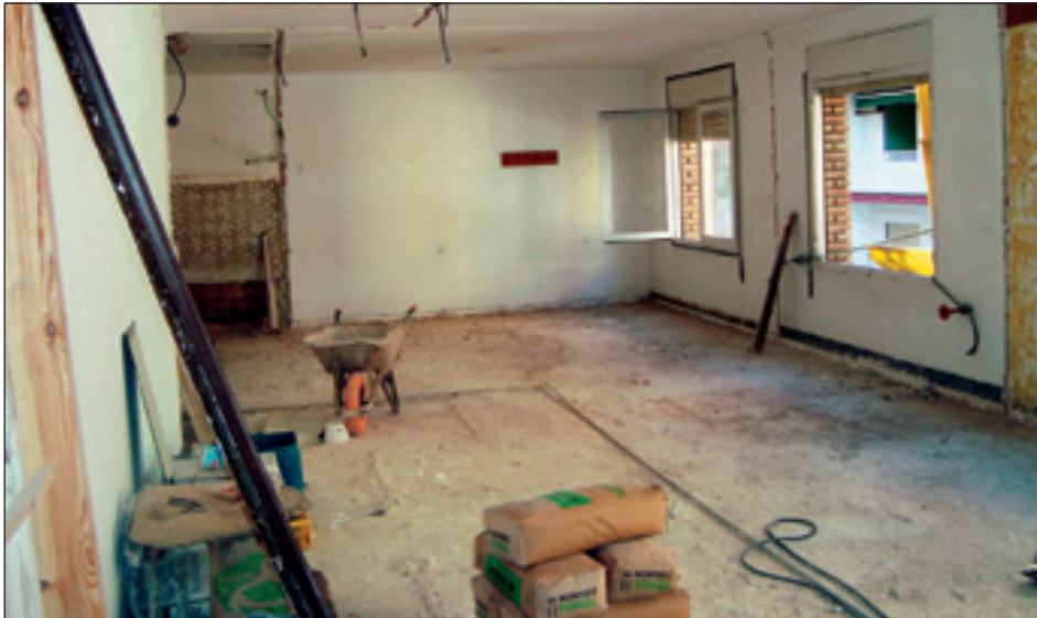
TREBALLS DE CONDICIONAMENT D'UNA DE LES PLANTES DESTINADES A L'HOTEL D'ENTITATS.
