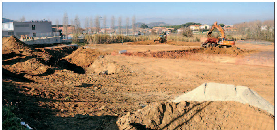
CANALITZACIÓ DEL TORRENT DE LES BRUIXES
