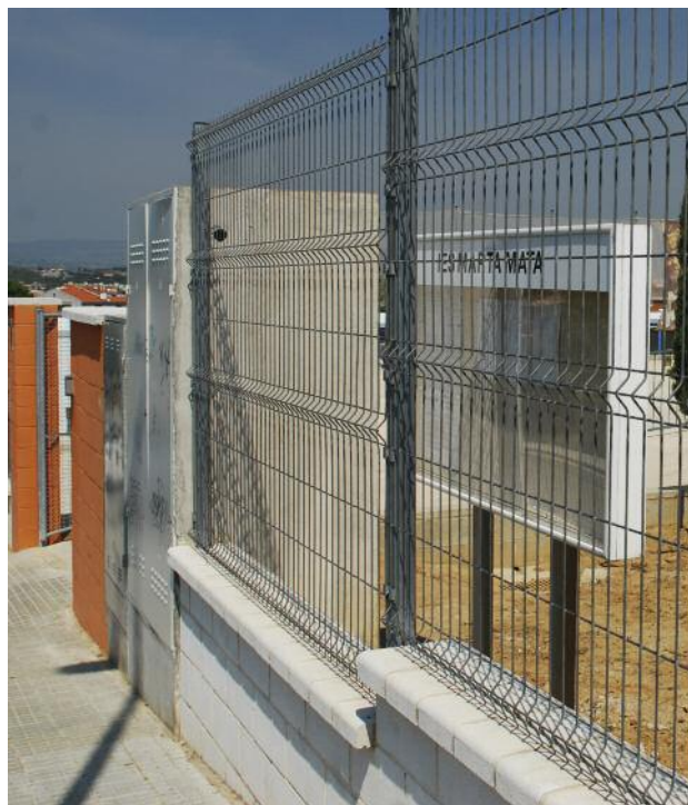
Instal·lacions actuals de l'Institut Marta Mata
