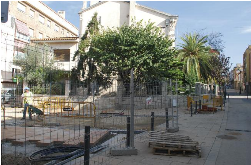
Ampliació de la zona de vianants del carrer Major amb la incorporació del carrer del Riu Mogent
