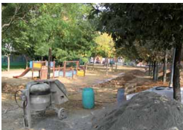
Obres a la plaça de l'Autonomia
