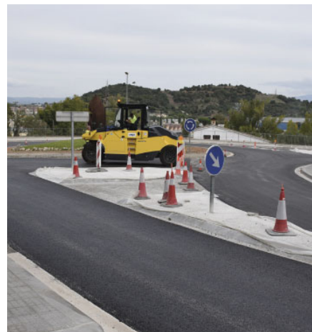
Obres a la rotonda de la BV-5001 i l'av. d'Ernest Lluch
