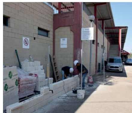
Instal·lació d'un dels ascensors a Les Vernedes
