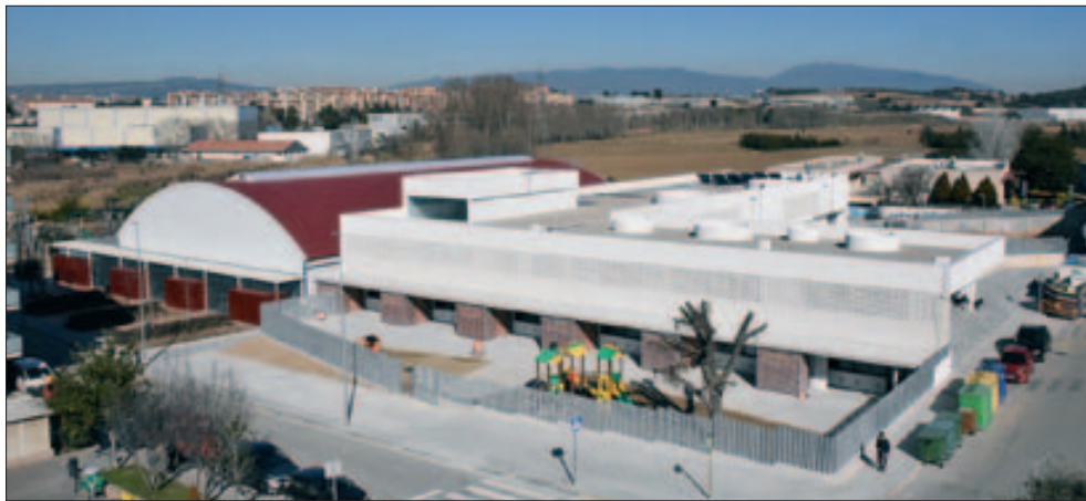
VISTA GENERAL DE L'EQUIPAMENT
