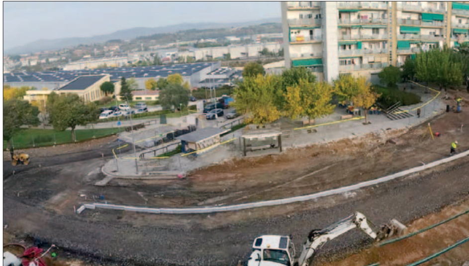
PANORÀMICA DE LES OBRES DEL CARRER DE LA LLIBERTAT
