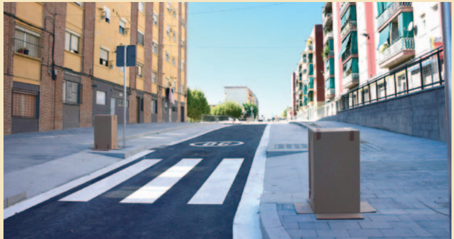
EL TRAM DE LA PRIMERA FASE DE LES OBRES, JA ACABAT
