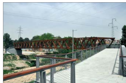
VISTA DE LA PASSAREA DES DEL CAMÍ FLUVIAL DEL RIU MOGENT
