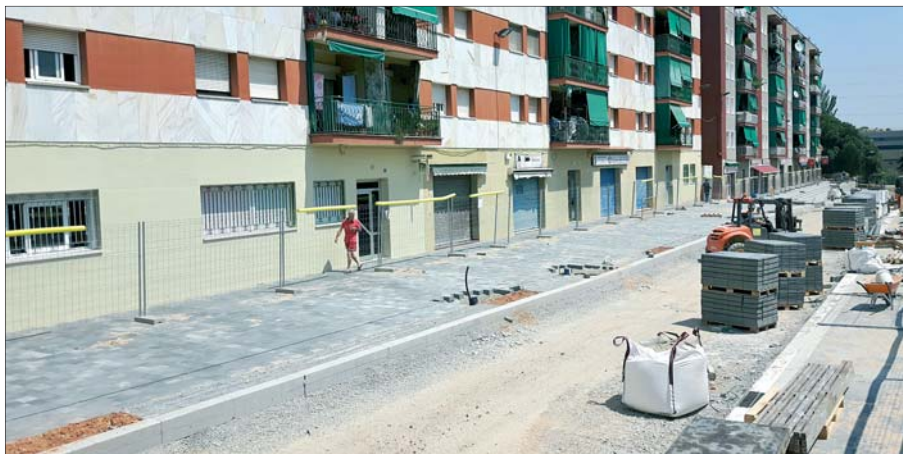
OBRES DEL PROJECTE DE REURBANITZACIÓ DEL CARRER DE LA LLIBERTAT
