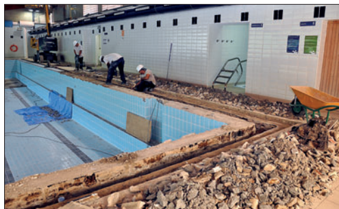
TREBALLS DE REPARACIÓ DEL CANAL PERIMETRAL DE LA PISCINA COBERTA GRAN
