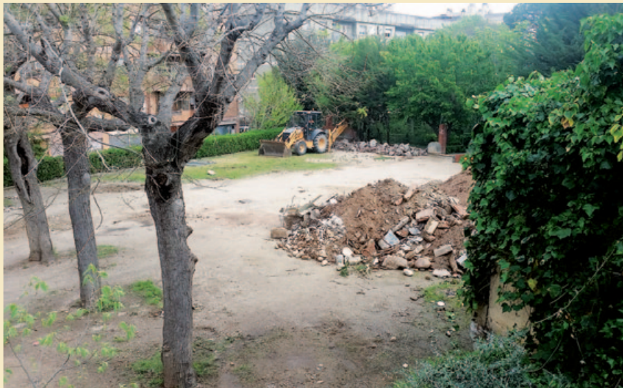
Reformes al Parc dels Castanyers. La Brigada Municipal d'Obres du a terme treballs de millora del paviment, la il·luminació i l'accessibilitat, i la renovació dels jocs infantils. |
