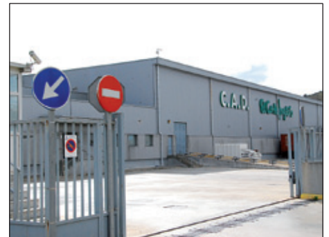
INSTAL·LACIONS DE LA PLANTA DE EL CORTE INGLÉS A
