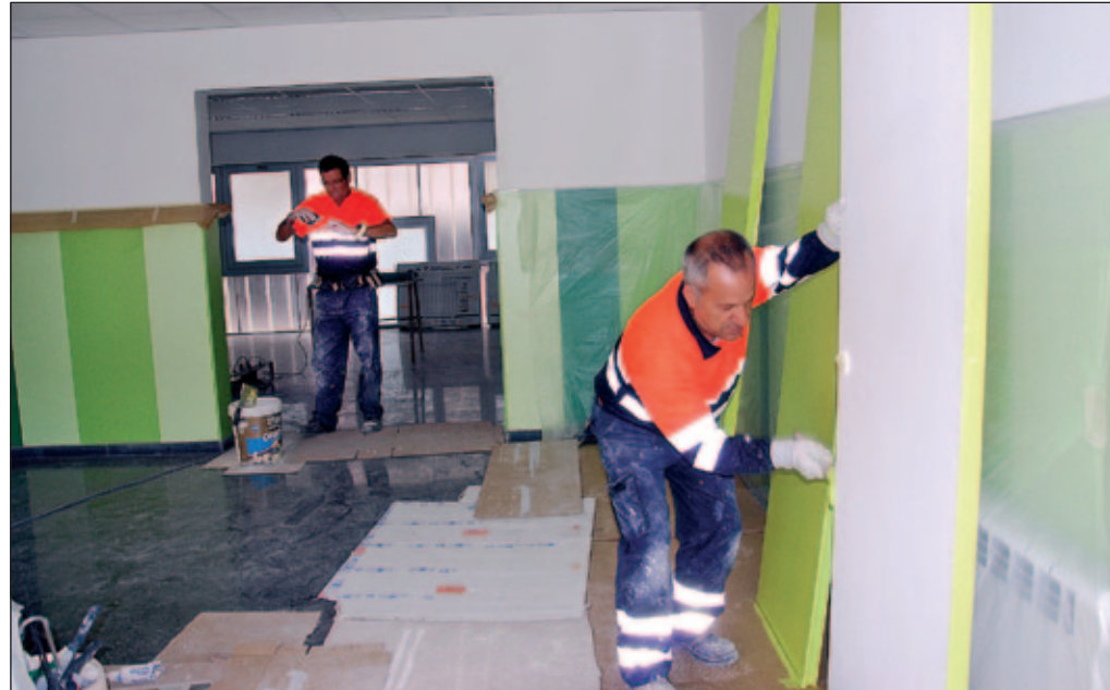
FEINES DE PINTURA EN EQUIPAMENTS
