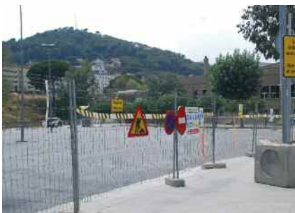
Asfaltat l'aparcament de la zona esportiva Pàg. 6
