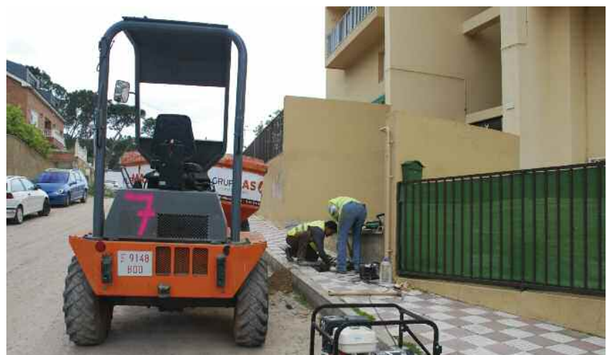
Primers treballs al carrer dels Pins
