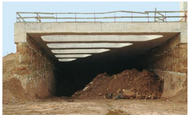
Obres del tram soterrat del traçat del TAV al costat de Masferrer
