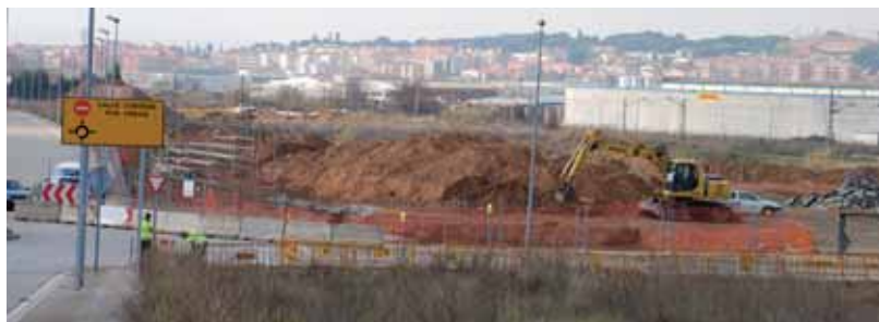
Obres del traçat de l'AVE a Montornès Nord
