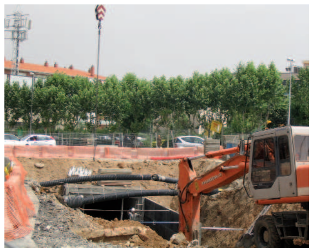
Obres al col·lector de Can Torrents
