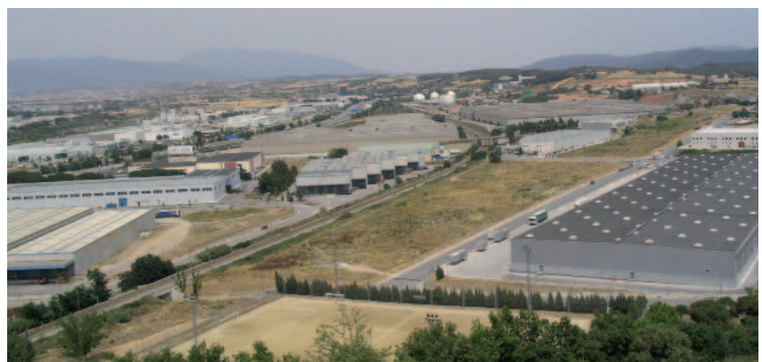
Terrenys municipals proposats per a la construcció de l'estació de rodalies
