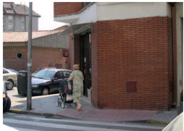
Vorera rebaixada al carrer Palau d'Ametlla
