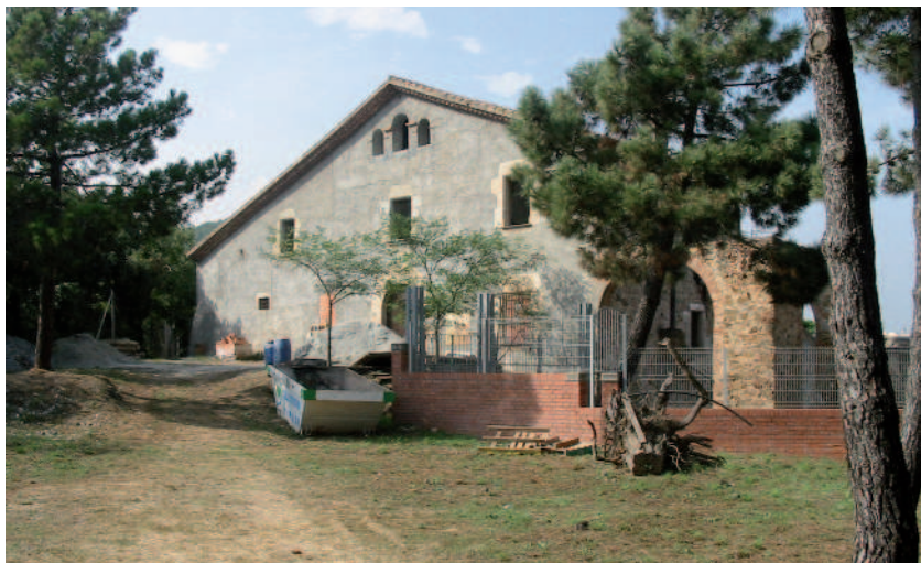
Treballs de millora dels annexos de la masia
