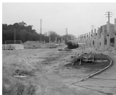
Obres als camps de futbol
