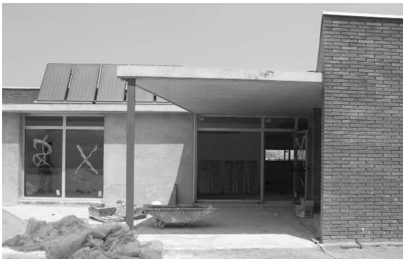
Obres de l'Escola Bressol al carrer Vallès
