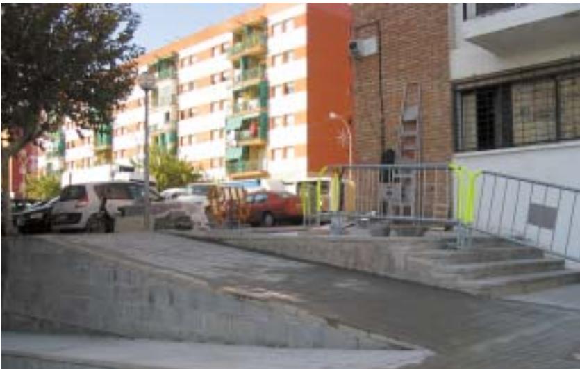
Rampes al carrer Nou d'abril
