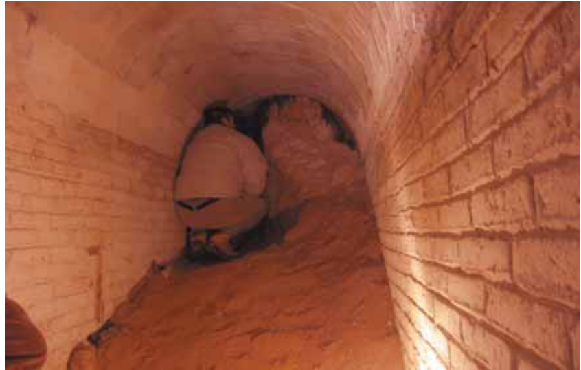
Primera inspecció de l'interior del refugi, el 27 de febrer
