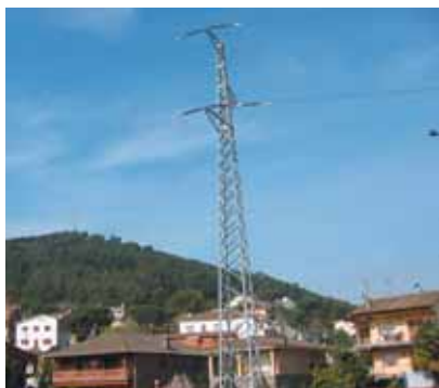
Soterrament de la línia d'alta tensió a Vinyes Velles: 800.000 euros
